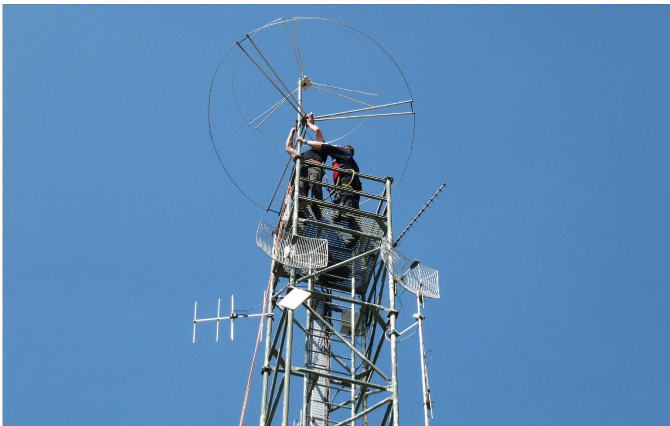
Déplacement de l'antenne Big Wheel LX0SIX et montage de la nouvelle antenne Big Wheel LX0FOUR, remplaçant l'ancien dipôle (juin 2014)
