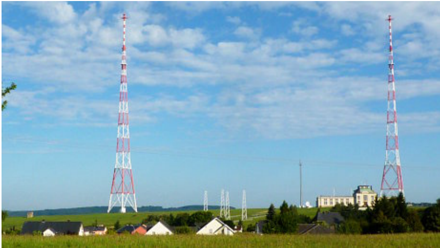
Sender Junglinster : Zwei der drei Langwellentürme, dazwischen der kleine Kreuzdipol für die Kurzwelle 6090 kHz
